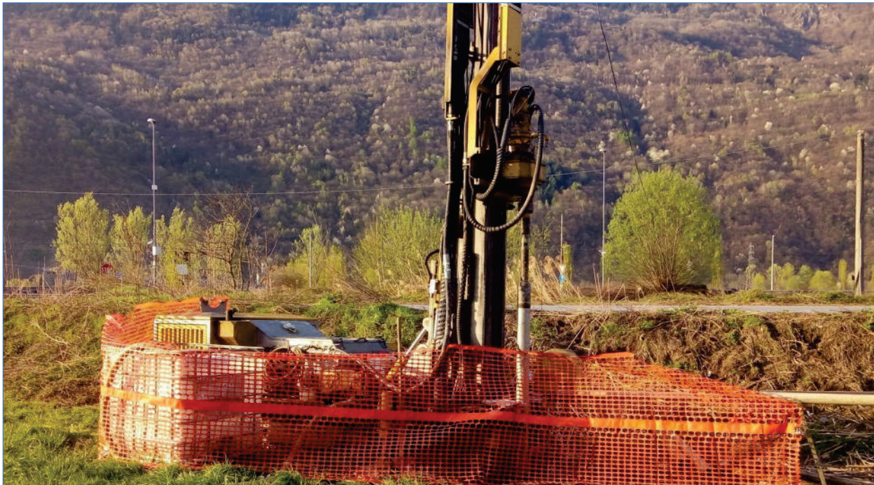
Postazione SONDAGGIO S1-DH
